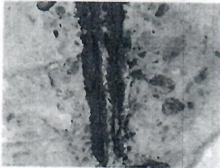
Imagem 5-Armadura corroída
