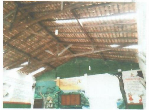
Imagem 10-Cobertura em estrutura de madeira
