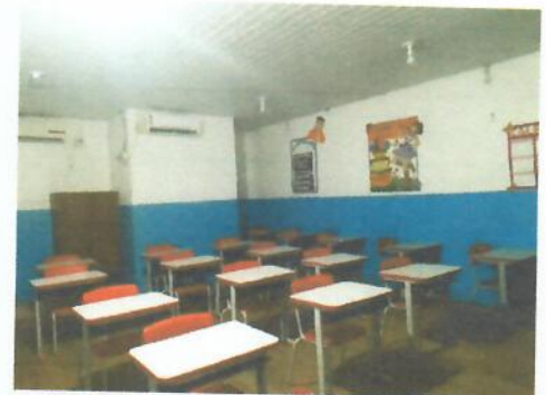
Imagem 18- Sala de aula no pav. Superior com piso em assoalho
