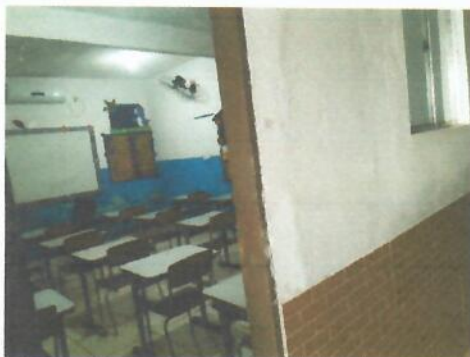
Imagem 7- Sala de aula
