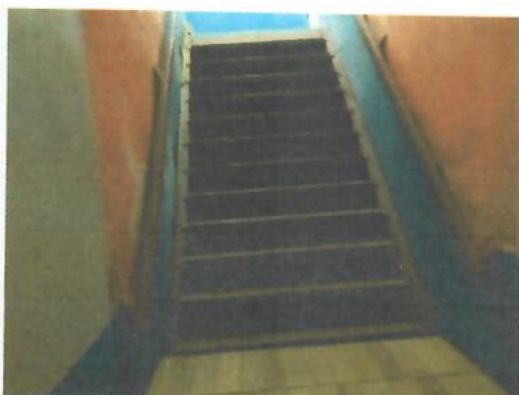
Imagem 21-Escada de acesso ao pav. superior
