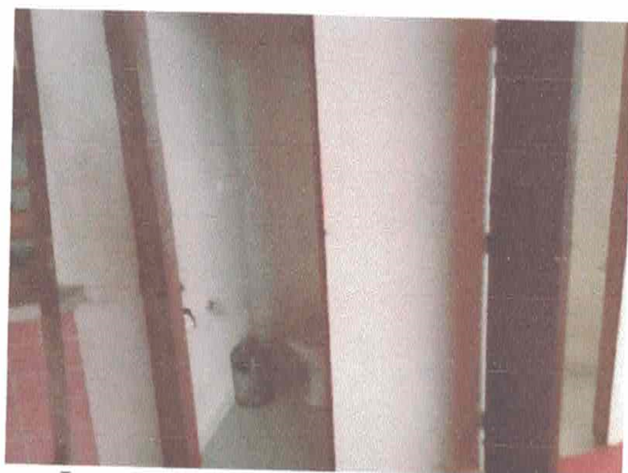
Imagem 14-Banheiro da área dos fundos
