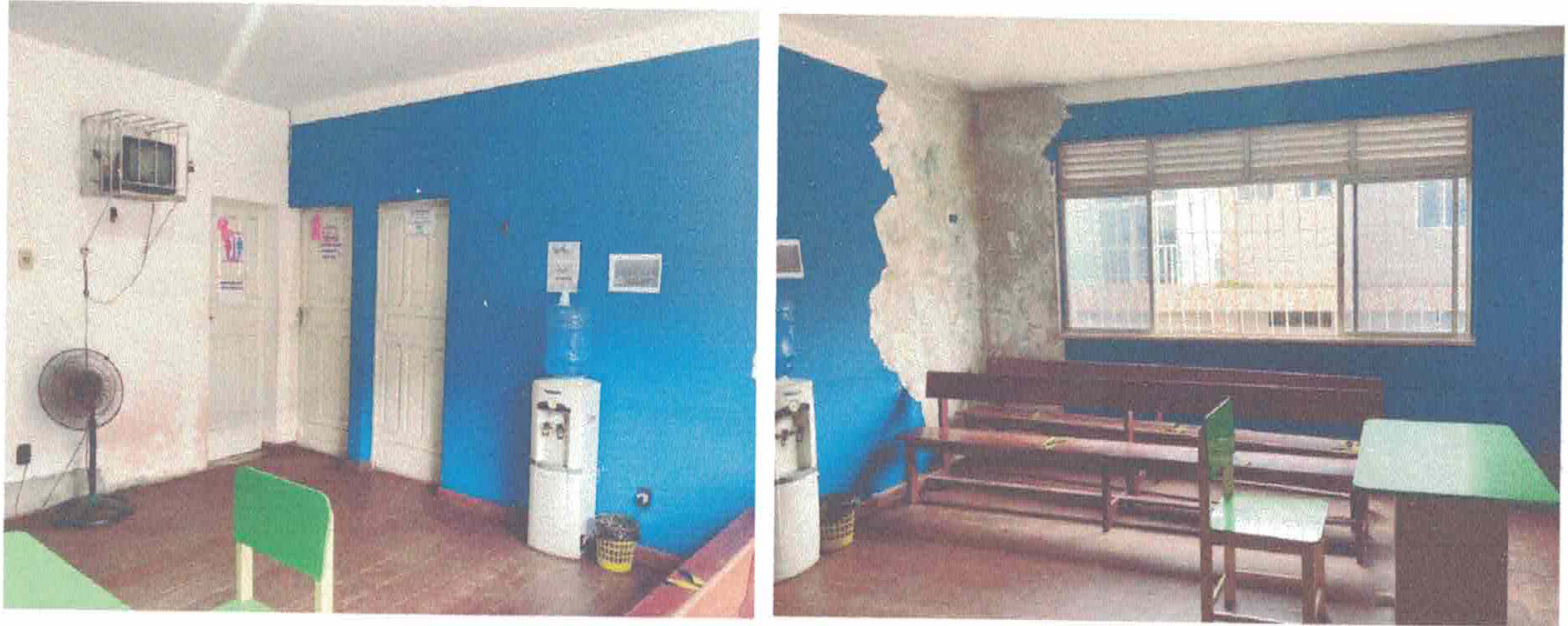
Figura 8 - Sala Habilitação/ Banheiro Habilitação
