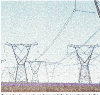
Segundo a Aneel, as torres de transmissão de energia derrubadas no Paraná e em Rondônia apresentam indícios de sabotagem
