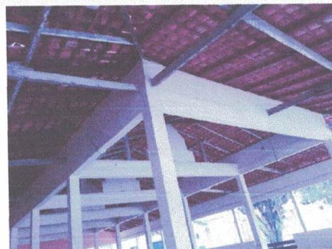
**Imagem 6 – Telha cerâmica colonial sobre estrutura de madeira e concreto armado**
