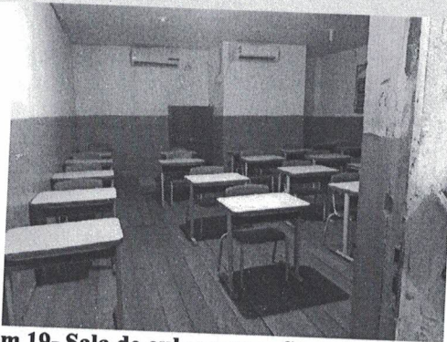
Imagem 19- Sala de aula no pav. Superior com piso em assoalho
