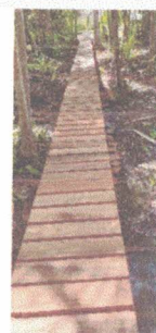
Imagem 8 - Passarela de acesso
