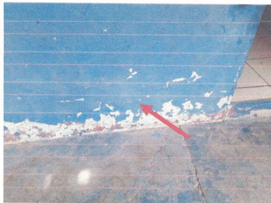
Imagem 10- Vigas com fissura, necessitando de reforço
