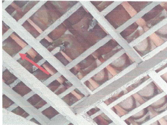
Imagem 14-Pintura e tabeira (vista) envelhecida
