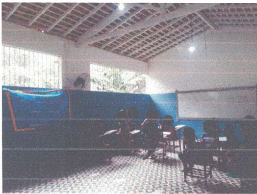
Imagem 15-Sala passível de receber forro, de trocar grades por janela de vidro
