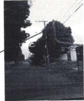
Posto de energia câmara 11
