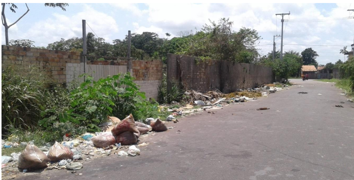
Figura 23 - Despejo de resíduos na rua Manoel de Abreu com João materno da Costa no bairro Cristo Redentor.
