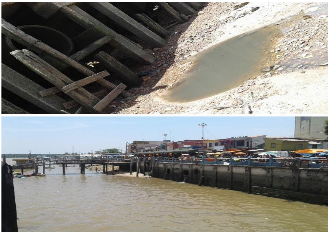
Figura 12 - Despejo de resíduos nas margens do Rio Maratauíra.
